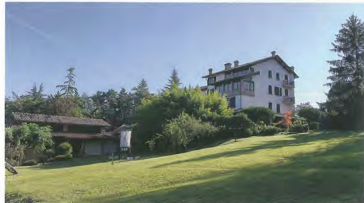
普伝寺本堂建設予定地→
