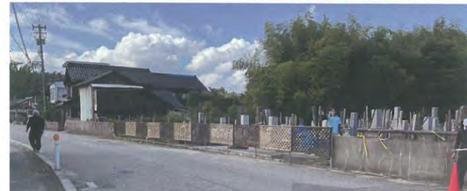
仮フェンス設置
