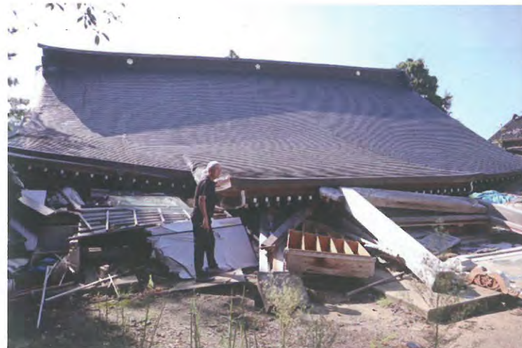
本堂が倒壊し、屋根が地面に落ちています。
